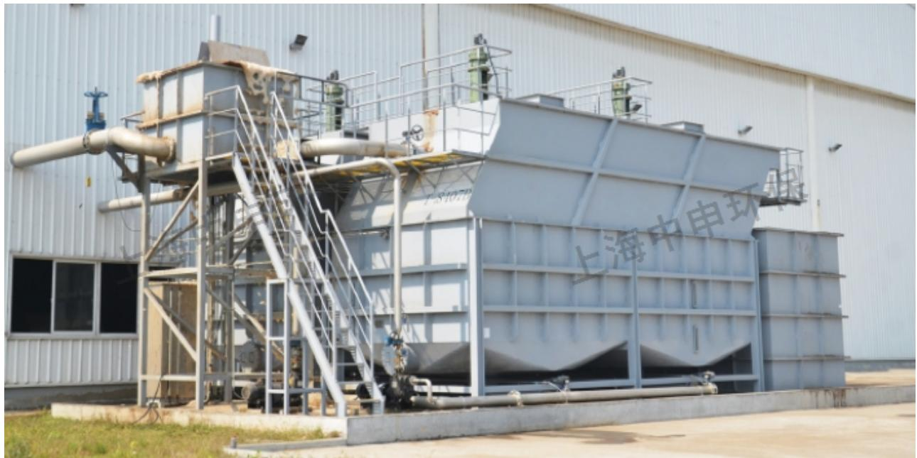
沉淀池池体平面为矩形，进口设在池长的一端，一般采用淹没进水孔，水由进水渠通过均匀分布的进水孔流入池体，进水孔后设有挡板，使水流均匀地分布在整个池宽的横断面。沉淀池的出口设在池长的另一端，多采用溢流堰，以保证沉淀后的澄清水可沿池宽均匀地流入出水渠。堰前设浮渣槽和挡板以截留水面浮渣。水流部分是池的主体。池宽和池深要保证水流沿池的过水断面布水均匀，依设计流速缓慢而稳定地流过。池的长宽比一般不小于4，池的有效水深一般不超过3米。污泥斗用来积聚沉淀下来的污泥，多设在池前部的池底以下，斗底有排泥管，定期排泥。对于已经在斜板和斜管上生长的藻类，可用高压水冲洗，往往一经冲洗即可去除附着的藻类。活性污泥处理系统的二次沉淀池是该系统的重要组成部分。二次沉淀池的运转是否正常，直接关
